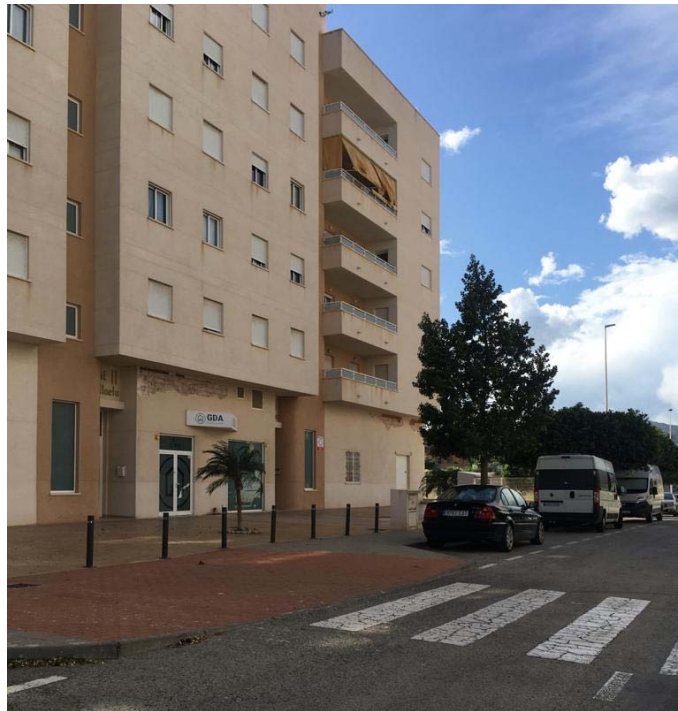
Bloque de viviendas y locales comerciales construido en calle Beniardá
