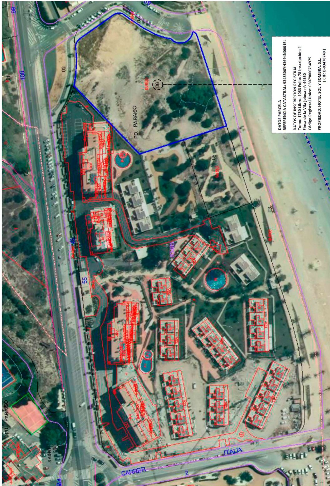
Localización sobre foto aérea de la Manzana TI-12 y la parcela nº 2 objeto de estudio de integración paisajística de uso Turístico-Hotelero (TH), propiedad de la sociedad Hotel Sol y Sombra, S.L.
